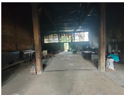
Gambar 2. Survey Lokasi, Bangunan, dan Fasilitas pada Pabrik Kerupuk X
